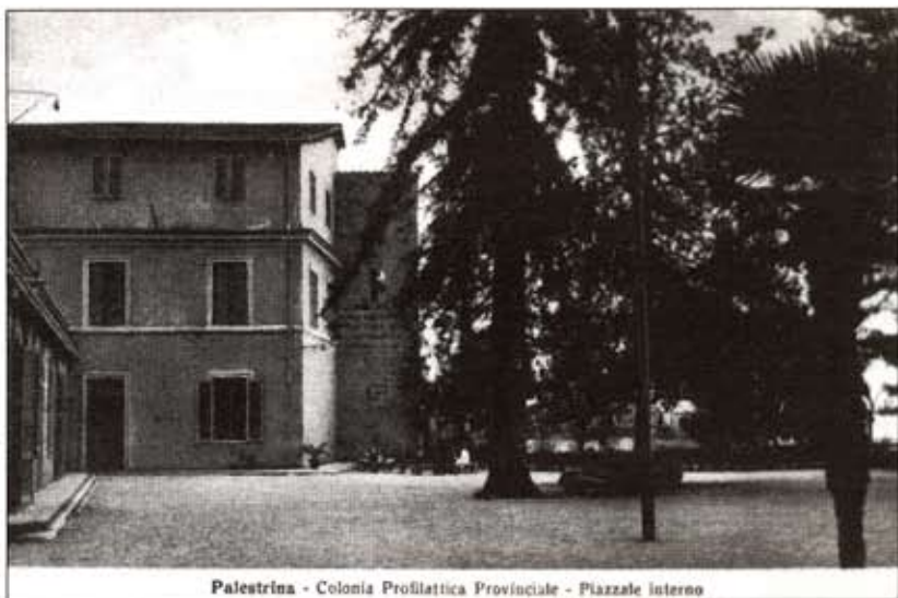
Palestrina - Colonia Profilattica Provinciale - Piazzale interno
