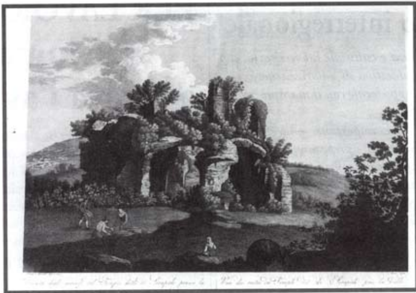
Sopra: veduta degli avanzi del tempio detto di Serapide (disegno e incisione di Francesco Morelli - 1800)
